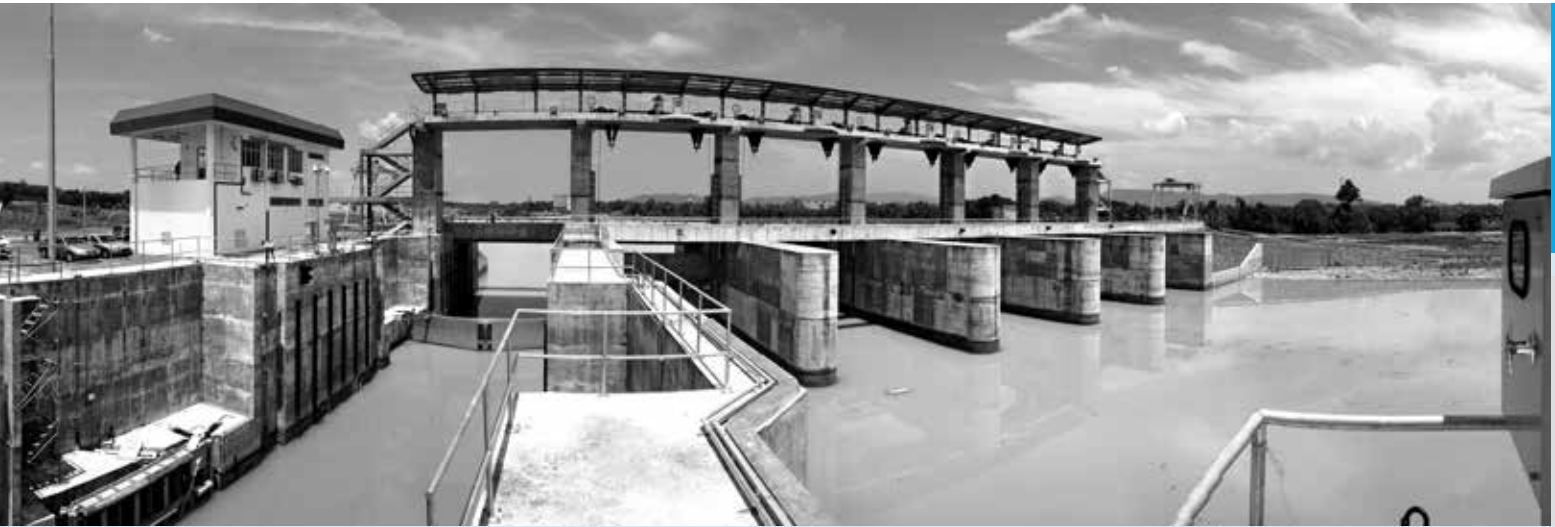
Sg. Johor Barrage
